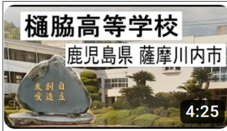
樋脇高等学校 (創立:昭和25年~閉校:平成21年)
