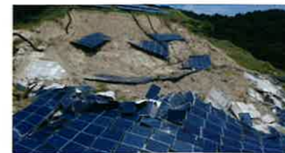
災害に起因した太陽光発電設備に係る被害例
