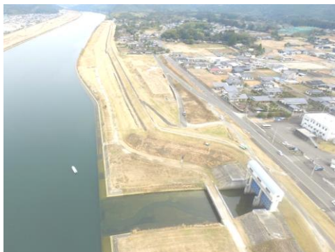
河川改修工事も急速に進んでいきます
