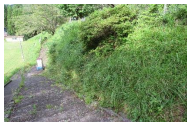
急傾斜地で作業に支障がある斜面
