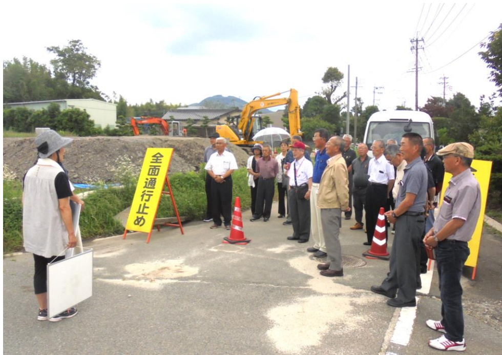
益城町東無田地区は122世帯のうち90世帯が全壊しました
