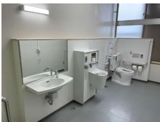
多目的トイレ
