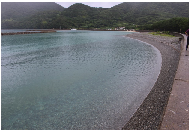
暴風対策を必要とする危険箇所の一部
