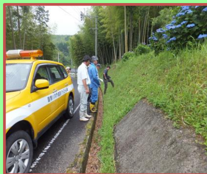
八重の法面吹付
