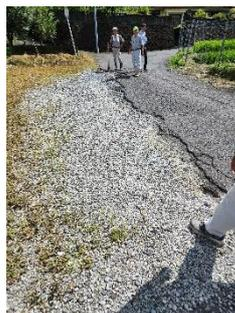
高木充子宅下の消防車庫の舗装が剥がれてくるので縁石設置要望
