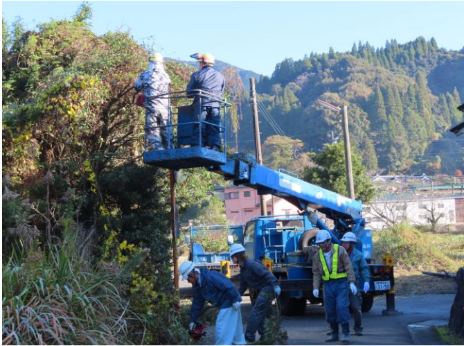
高所作業車による伐採作業
