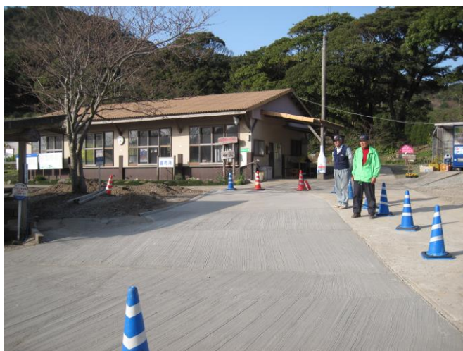
生コン打設作業終了後の通路
